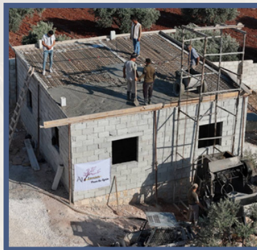
Maison en cours de construction - Syrie, Janvier 2024
