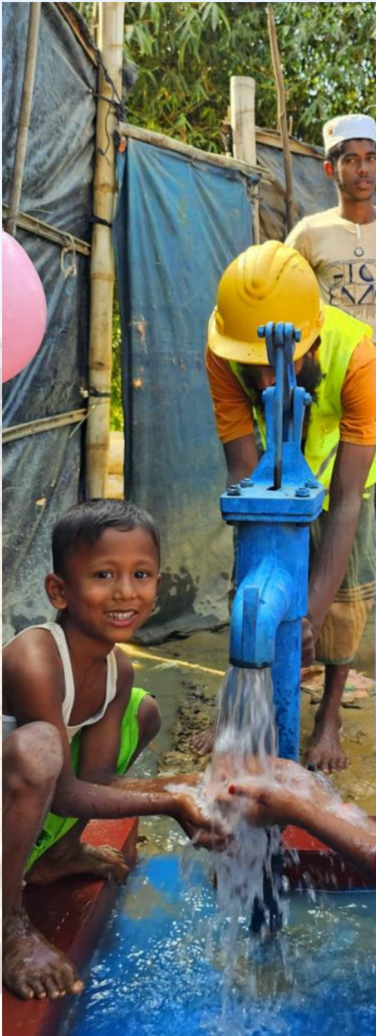
Construction de puits - Bangladesh
